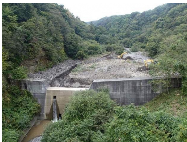
写真 4.4.1 除石工の事例（御嶽山）
