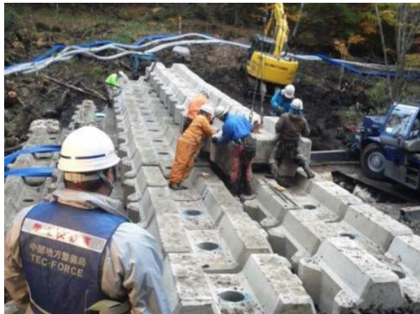
写真 4.4.3 ブロック堰堤工の事例（御嶽山）
