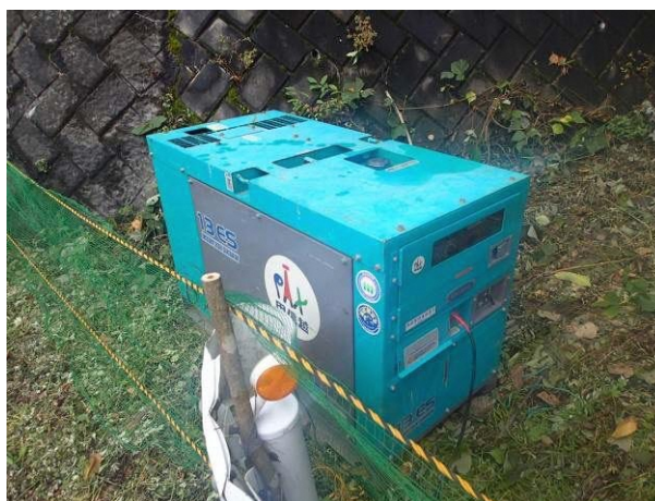
写真 5.2.1 監視カメラ設置時の発電機の例 (御嶽山)
