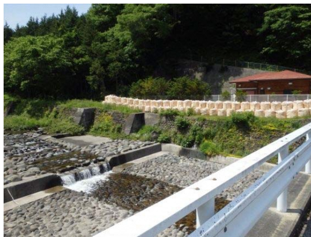
写真 4. 4. 4 導流堤工の設置事例（御嶽山）
