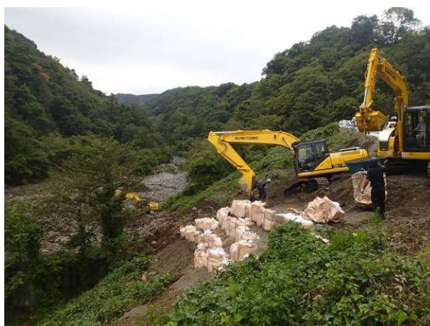
写真 4.4.2 仮設道路設置の事例（御嶽山）
